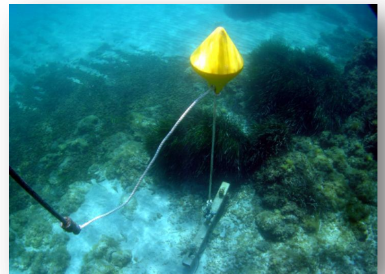
Ancre à vis en rade d'Agay
