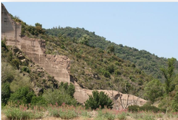
Ruines du barrage de Malpasset
