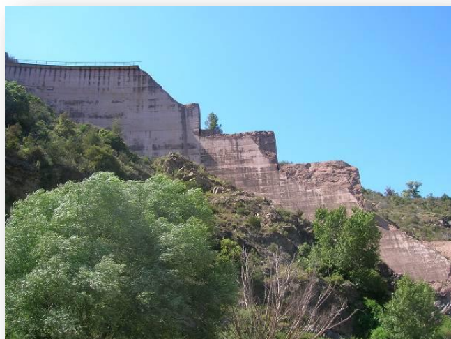
Ruines du barrage de Malpasset
