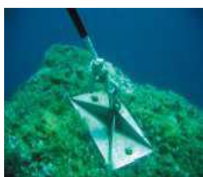
Scellement d'ancrage sur roche
